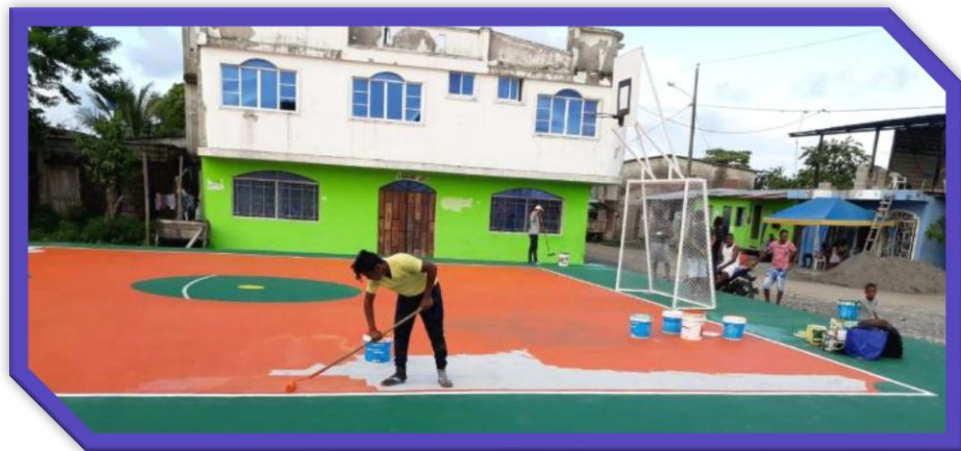
CONSTRUCCION DE LA CANCHA DE USO MULTIPLE EN ROMPIDO
